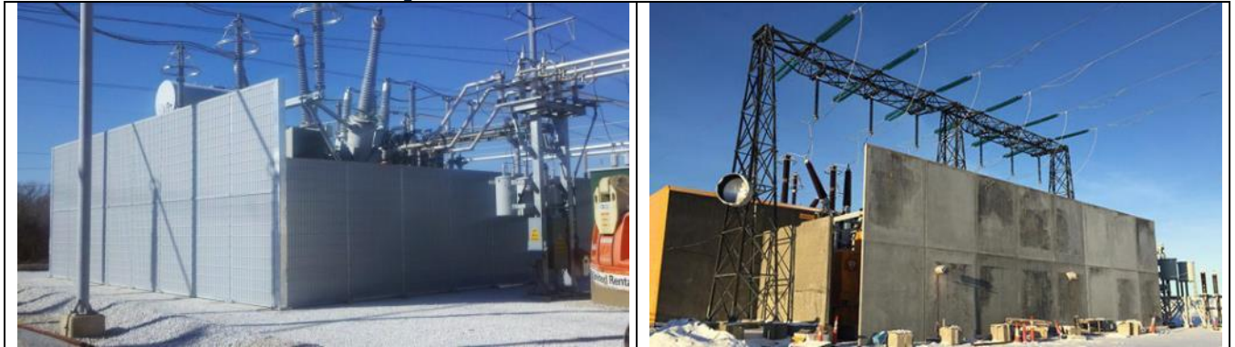
Ilustración 10: Fotografías de referencia de barrera acústica en subestaciones eléctricas.
